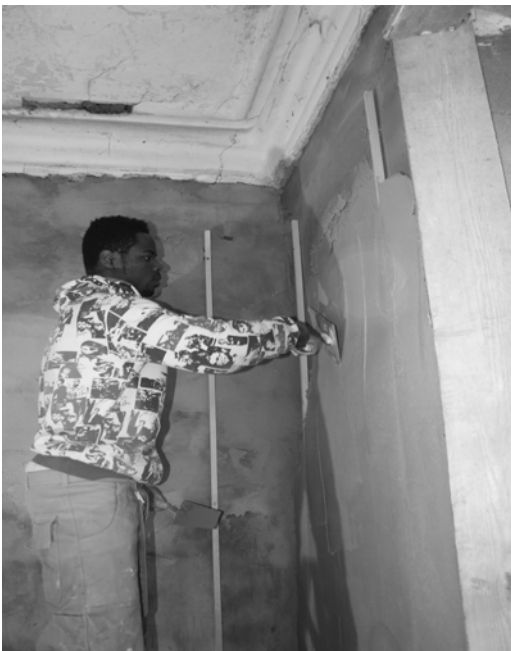
Kalksandputzarbeiten im Jugendschloss
