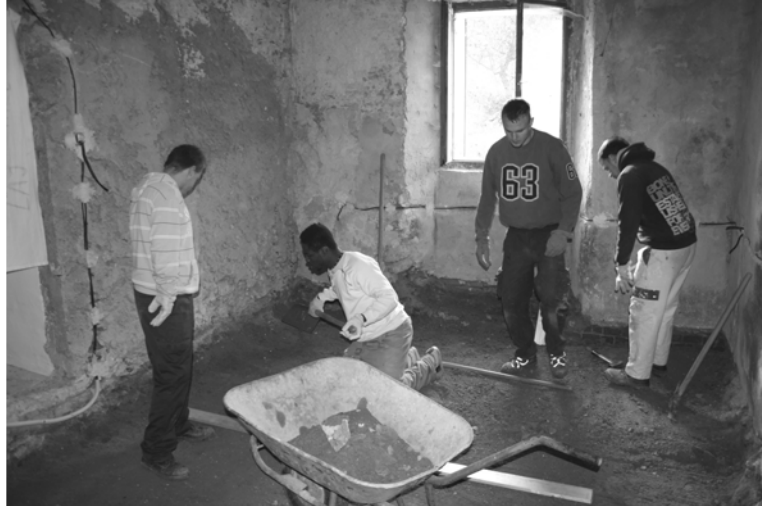
Estrichlegen im Erdgeschoss
